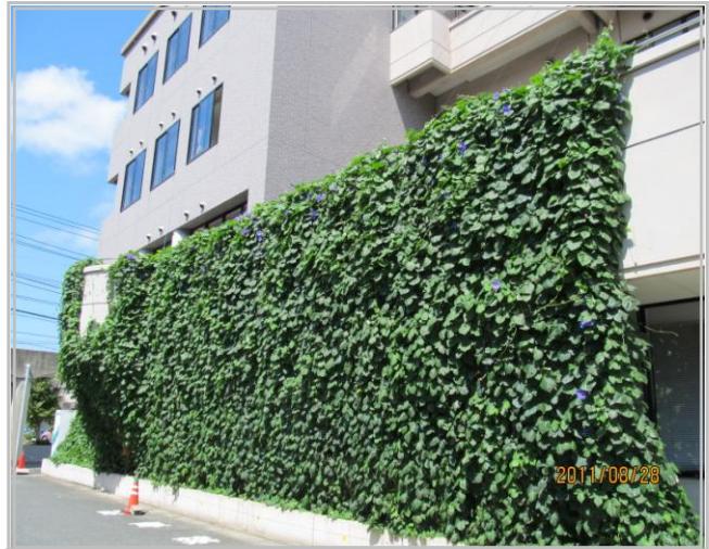
1階をすっかり覆ってしまいました (H23)
